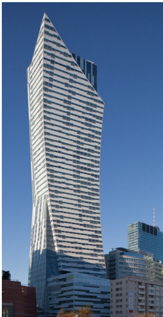
Budynek biurowy Żłota 44 projektu Daniela Libeskinda słynnego amerykańskiego architekta pochodzenia polsko-żydowskiego.
